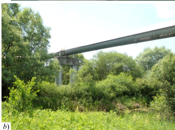
Рис. 1. Перехід надземної ділянки МГ через: а) русло річки; б) заболочені ділянки / Overpasses of the above-ground segments of the pipeline: а) across riverbed; б) over wetlands
