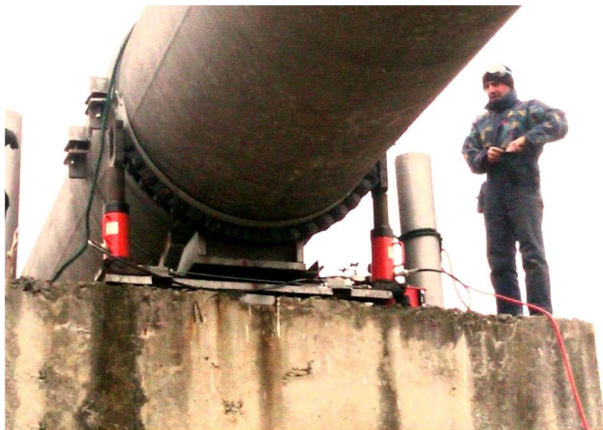
Рис. 2. Установка мобільного підйимального пристрою на опори МГ / Installation of a mobile lifting device on the support of the pipeline
