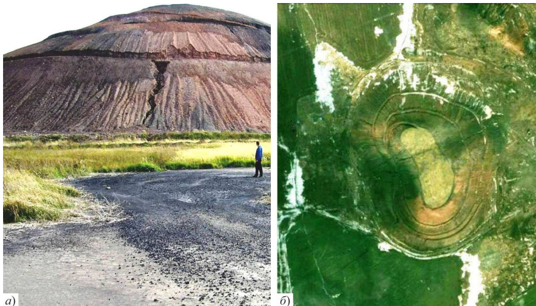
Рис. 1. Прояви водної ерозії (а) і забруднення ґрунтового покриву агроландшафтів внаслідок ерозії та надходження відвальної породи та хімічних речовин (а, б) з відвалу шахти "Матроська" ПАТ "Лисичанськвугілля".
