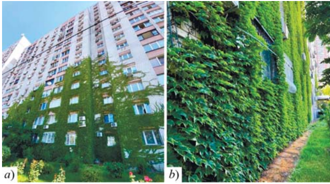
Рис. 2. Паростки винограду "Вічі", висаджені біля будівлі Дарницької райдержадміністрації у межах ініціативи "Місто живих стін" / prouts of the Vichi grape variety planted near the Darnytsia District State Administration building as part of the "City of Living Walls" initiative [17]
