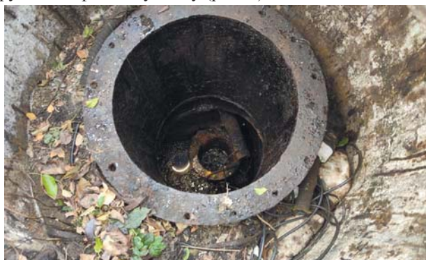
Рис. 1. Шурф, облаштований залізобетонними кільцями та колоною / Pit equipped with reinforced concrete rings and a column
