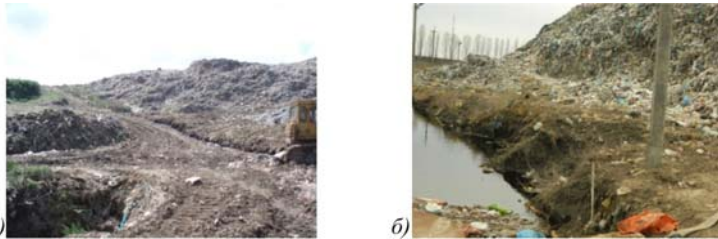
Рис. 4. Зсуви: а) на Львівському міському полігоні ТПВ; б) на Хмельницькому міському полігоні ТПВ (фото автора)
