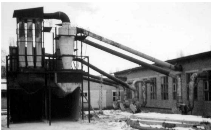
Рис. 3. Послідовне підключення циклона та рукавних фільтрів на Кременчуцькому МК
