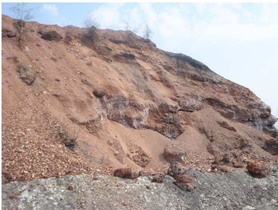
Рис. 3. Виникнення зсувів на териконі шахти №4
