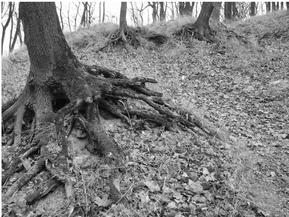
Рис. 1. Оголення кореневої системи внаслідок змиву ґрунту
