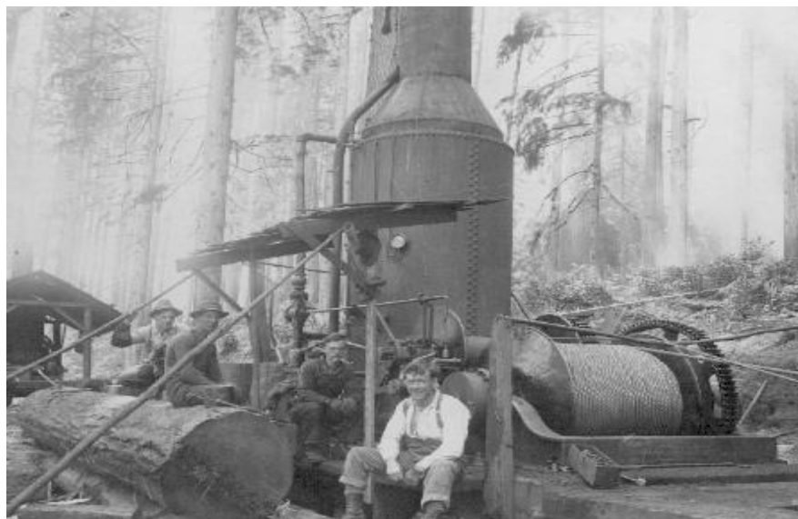
Рис. 4. Компонування лебідки з паровою машиною
